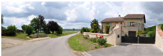
Nouvelles constructions en entrée de village à Bouillonville, Vallée du Rupt de Mad et à Broussey-Raulecourt, plaine de la Woëvre (source : PNRL)
