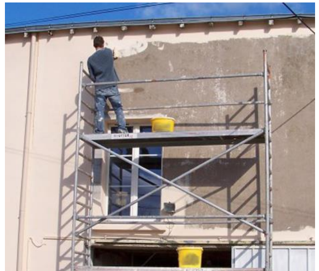
1- Travaux de façade pouvant impacter la reproduction des Hirondelles de fenêtre
